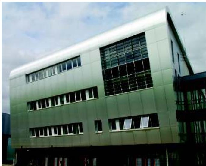
WILLSTRONG® Brushed Plus氟碳拉丝铝复合板，应用铝的自然拉丝工艺和氟碳辊涂工艺，以增强产品金属质感和抗侵蚀的特性，使其兼备时尚和科技的元素。外观饰面具有非常强的金属质感，可与不锈钢拉丝擦纹板相媲美，纹理清晰、均匀、时尚感强，给人以强烈的视觉吸引。具有超强的耐温、耐候、防火性能，而且耐污易清洁，是当今时尚流行的新型高档装饰材料，特别适用于高档写字楼、商务酒店、集成吊顶天花，内墙装饰及高档家用电器的外饰板装饰。
